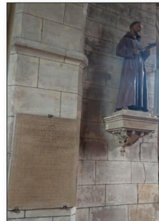
Dans un premier temps, l'entretien se fera par la réfection des éléments en pierre de taille endommagés sur la partie basse de l'église et la reprise des joints. Piquage des parties cimentées joints et parements par un remplacement des éléments atteints par des pierres similaires et saines. La taille et la pose se feront à la chaux de Saint Astier.
